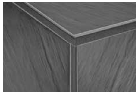
Réalisation d'angles avec coupe en onglet
